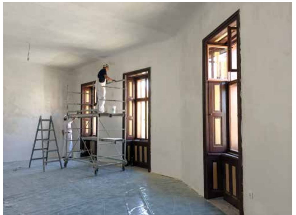
Prostorija Udruge umirovljenika pri završetku radova
