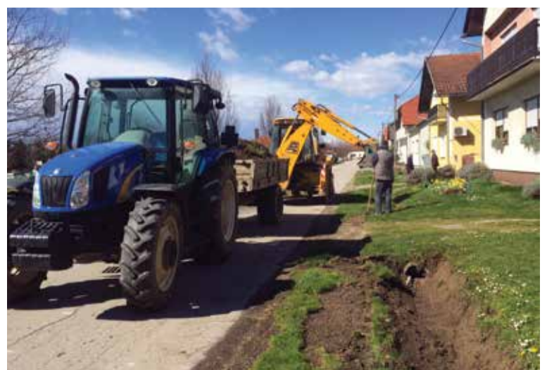
Čišćenje odvodnih kanala
