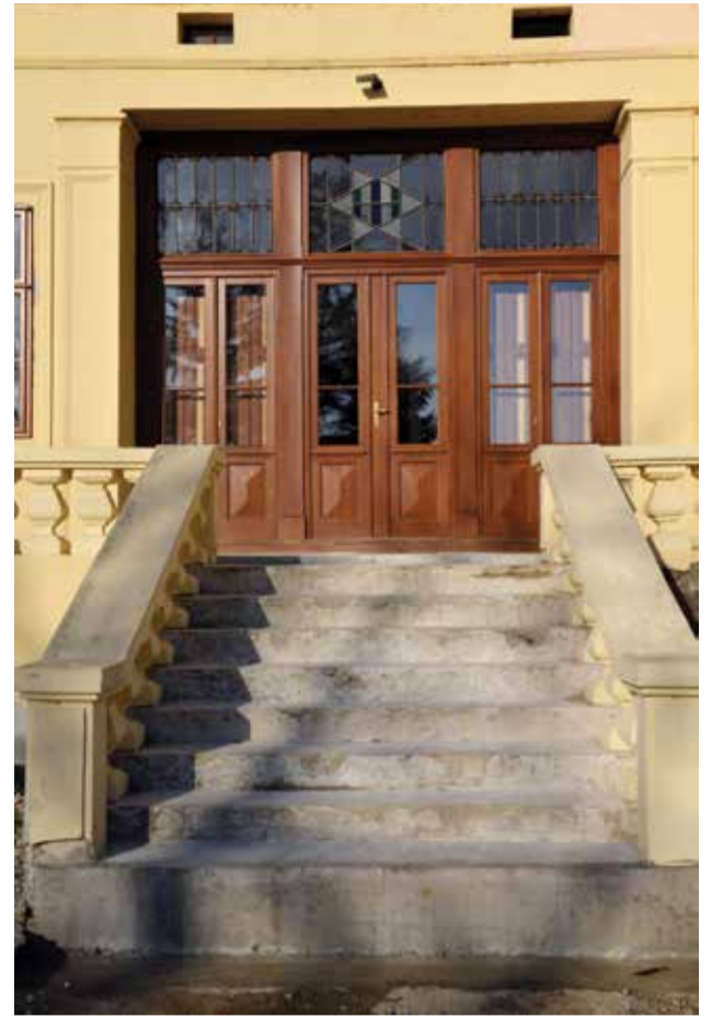
Obnovljena ulazna vrata i radovi na stepeništu "Zalana"
