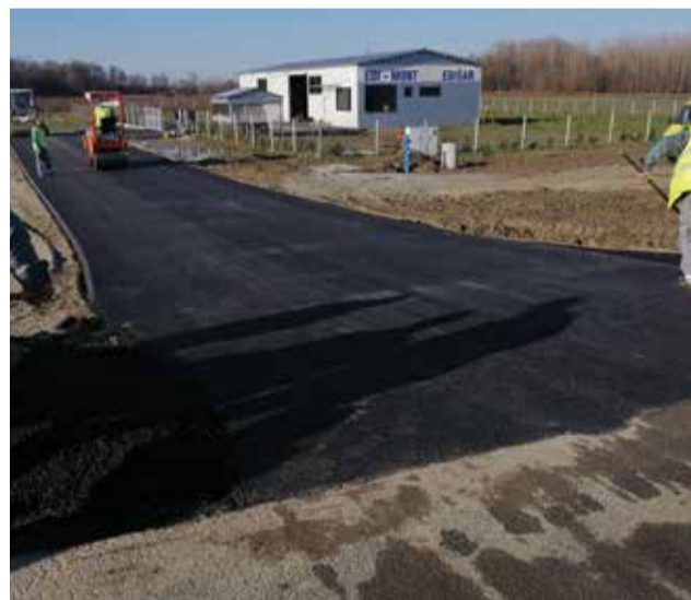
Postavljanje novog asfalta u gospodarskoj zoni
