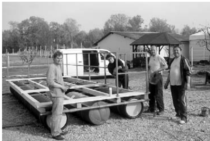
Izgradnja i postavljanje novog privezišta za čamce
