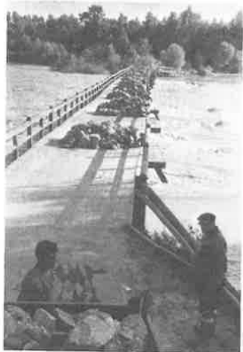
Stari (prvi) dobravski drveni most preko Drave: 1965. opterećen je sa 66 tona kamenja kako ga bujica ne bi odnijela
