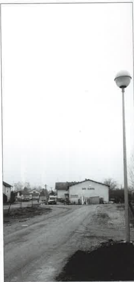
Montaža kandelabera i proširenje te asfaltiranje Koprivničke ulice
