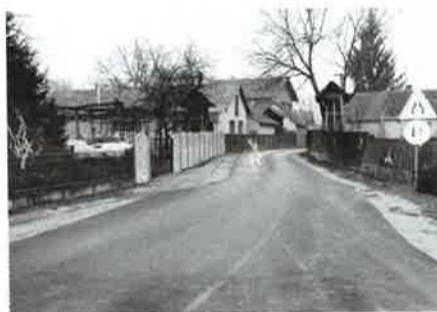
Asfaltirana je Brodarska ulica
