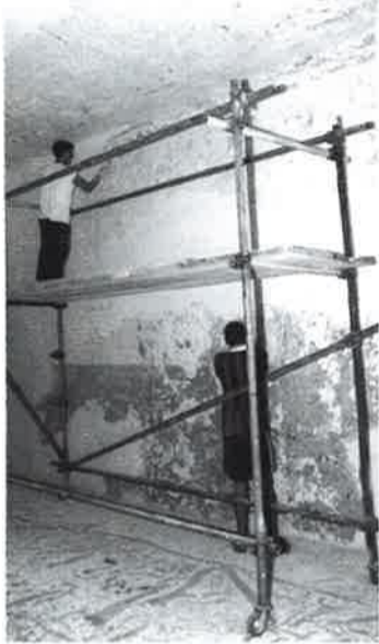
Radovi na obnovi Doma kulture «Zalan»
