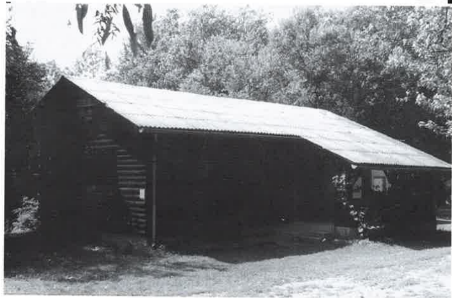
Obnovljeno krovništvo ribičkog doma
